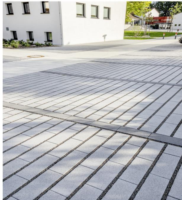
Referenzbild: Betonpflaster mit Splittfuge
